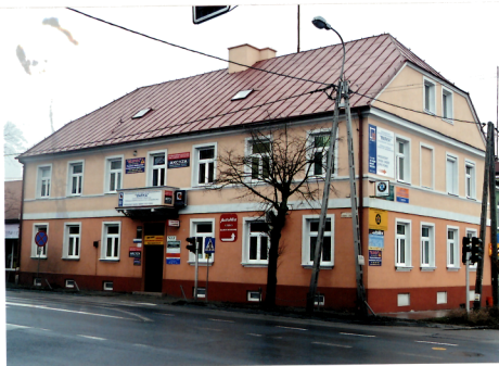
Widok elewacji frontowej od strony południowo-zachodniej. Fot. Łukasz Wasiak
